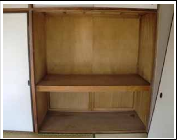
押入れ内部点検口状況
