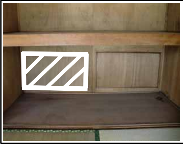
南側押入れ開口部(既存点検口の場合)
